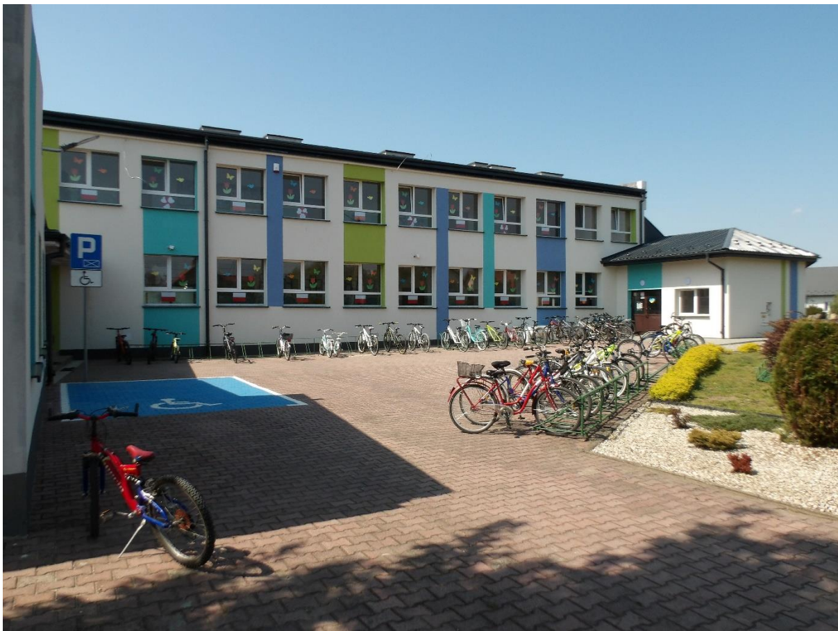
Głęboka termomodernizacja Szkoła w Rudce
